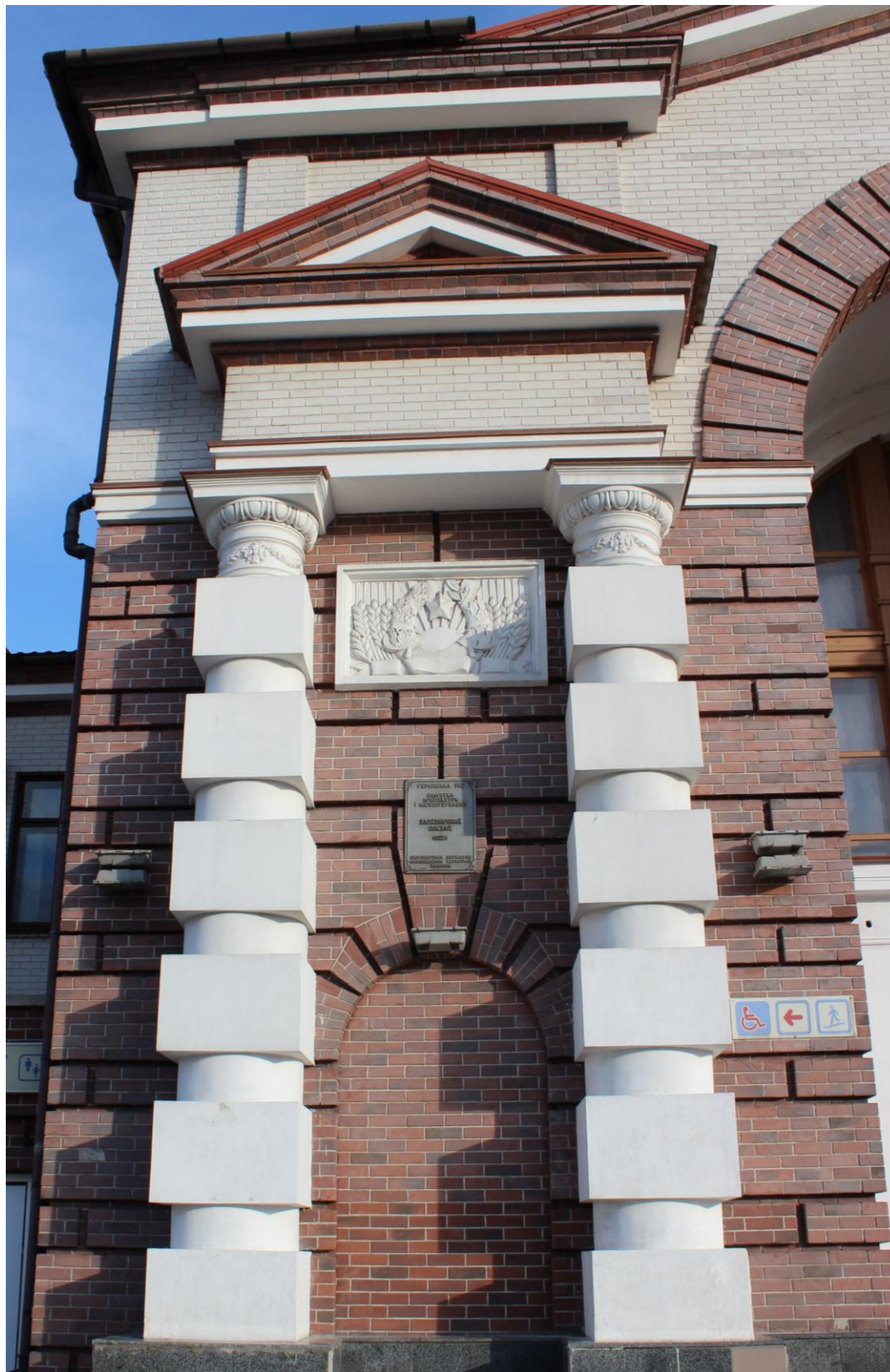
Фото 6. Памятник градостроительства и архитектуры «Железнодорожный вокзал» – фрагмент фасада, дата съемки 15.07.2020 г.
